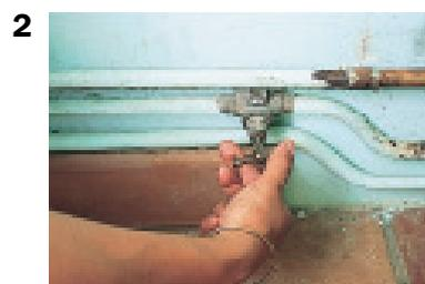
**2. Fermer le robinet d'arrêt sur la canalisation d'arrivée d'eau.**
