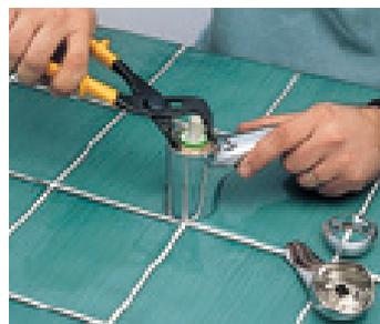
1. La vis d'assemblage de la tête est cachée derrière la pastille de couleur d'eau froide eau chaude.
